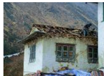
先日の烈風で破損した屋根を修復中
